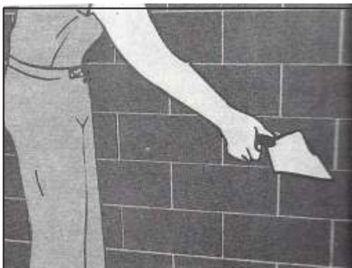
10. Limpieza de derrame de mortero
