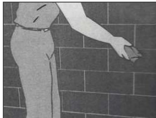
10. Limpieza de derrame de mortero
